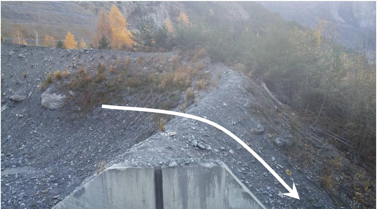
**Photo 31** : Surverse massive sur une digue sans érosion significative.
